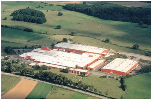
Штаб-квартира и завод в г.Мамер (Люксембург)
